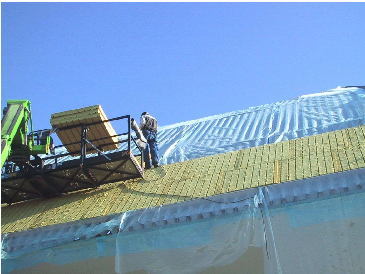
Kuva 2 Lämmöneristeiden asennus rakennustyömaalla.
