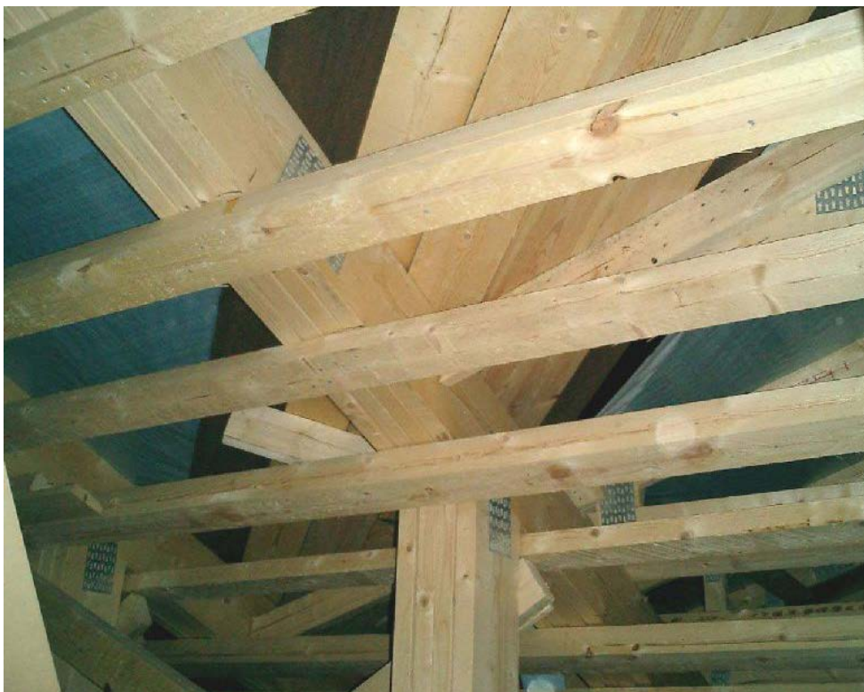
Kuva 2 Kuva korjatusta rakenteesta.
