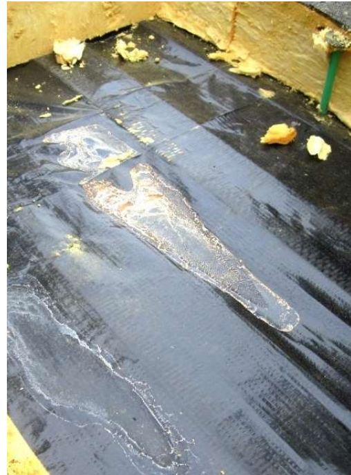
Kuva 1. Vasemmalla: yläpohjan höyrinsulkua ei ollut liitetty tiiviisti ulkoseinään; oikealla: kosteutta höyrinsulun päällä (kuva Ramboll Finland Oy).
