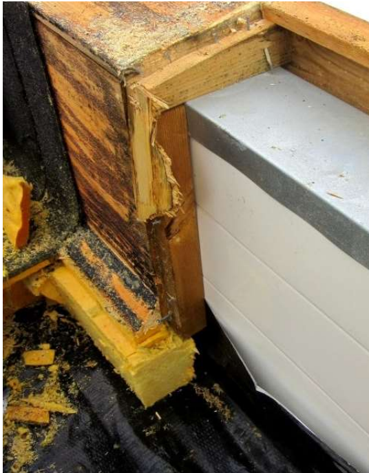
Kuva 1. Vasemmalla: yläpohjan höyrinsulkua ei ollut liitetty tiiviisti ulkoseinään; oikealla: kosteutta höyrinsulun päällä (kuva Ramboll Finland Oy).
