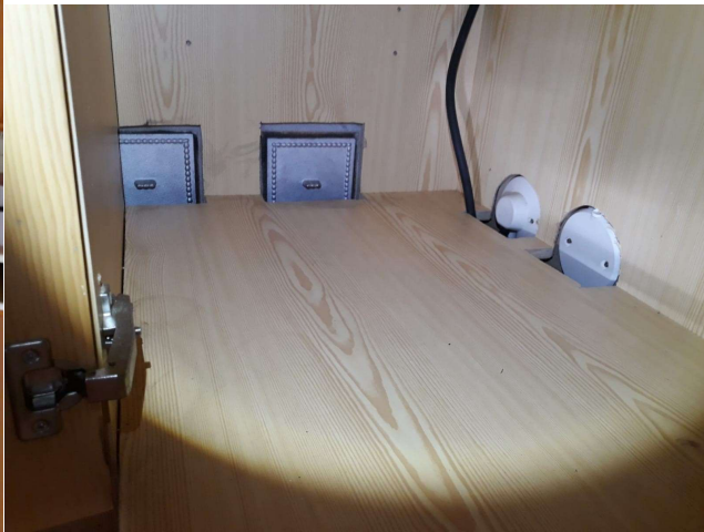
Kuva 1. Paikalla muurattuun savupiippuun virheellisesti kiinnitettyjä kalusteita.
