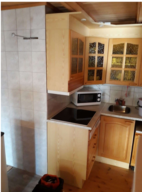
Kuva 1. Paikalla muurattuun savupiippuun virheellisesti kiinnitettyjä kalusteita.
